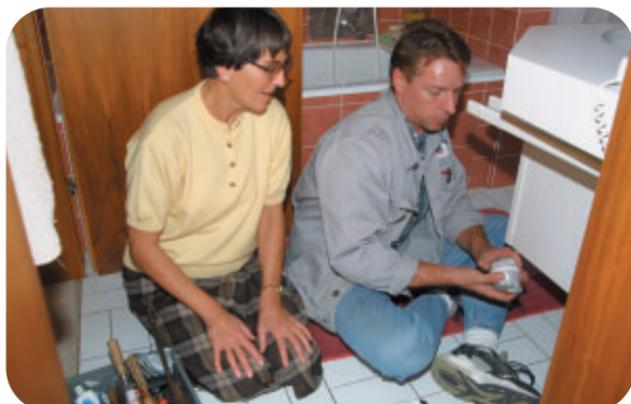
Neuer Wasserzähler. Aber wohin damit? Der Schrank hängt zu nah. Die Leiste lässt keine Luft. Günther Kuhn baut vor, die Leiste wird überbrückt, der Zähler montiert.
