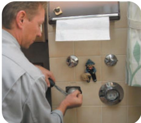
Klassischer Fall. Wasserzähler austauschen. Zum Glück ist dieser hier leicht zugänglich. Ein letzter Test und er läuft und läuft ...
