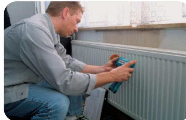
Letzte Vorbereitungen. Der Lack muss ab. Die Heizung ist vermessen. Ran mit dem Bolzenschweißgerät und der Techem-Technik. Arbeit am Heizkörper – abgehakt.
